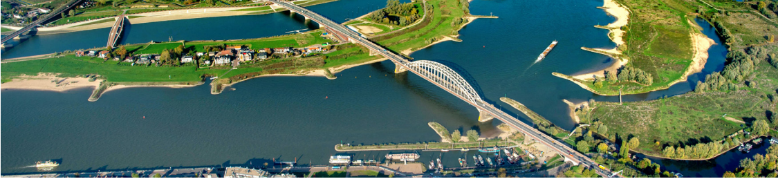
De Waalbrug en Verlengde Waalbrug, de verbinding tussen centrum Nijmegen en de Lentse Ooijpolder
